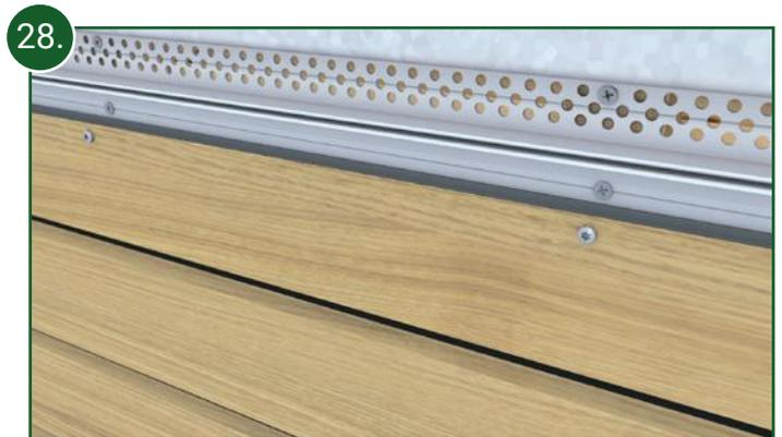
28. Anschließend wird das Fassadenprofil mit den Fassadenschrauben entsprechend fixiert.
