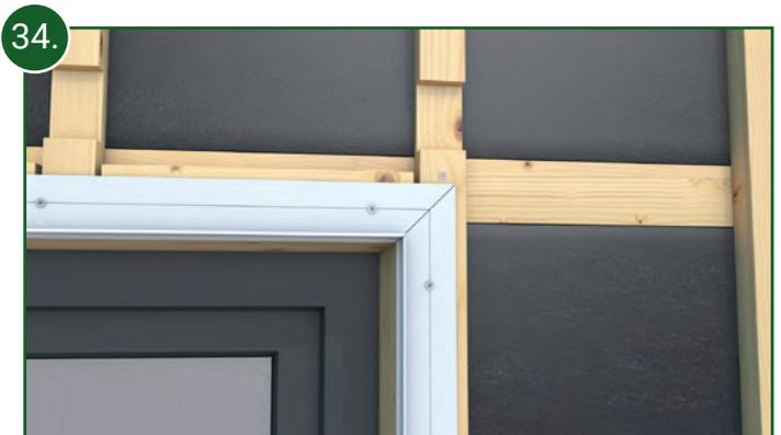
34. Montieren Sie die Unterteile der 2-teiligen Abschlussprofile bündig entlang der Fensterleibung. Die Eckverbindungen erfolgen per Gehrungsschnitt. Zur vollflächigen Auflage der Unterteile muss die Traglattung horizontal aufgefüttert werden.
