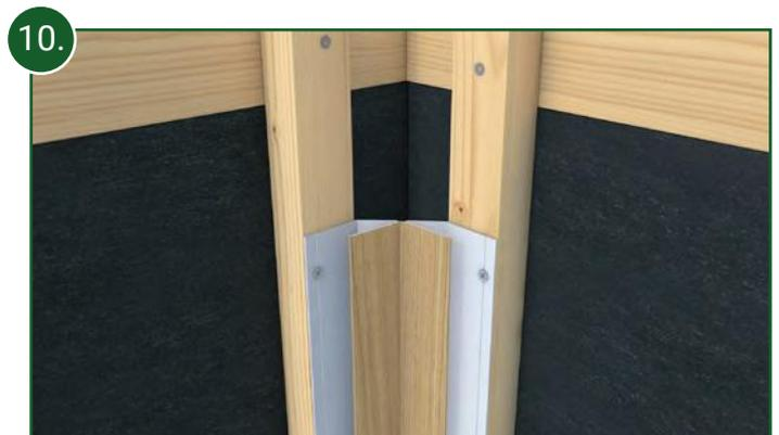
10. Das variable Eckprofil wird mittels Schrauben entlang der eingebrachten Schraubnuten im Abstand von 40 cm mit den Traglatten fixiert.
