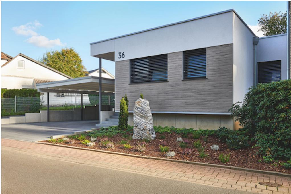
2 Der Flachdachbau wurde auskragend über dem Betonsockel errichtet, was im Zusammenspiel des farblichen Kontrastes der Fassadenprofilen zu den weiß verputzten Flächen dem Baukörper Leichtigkeit verleiht.
