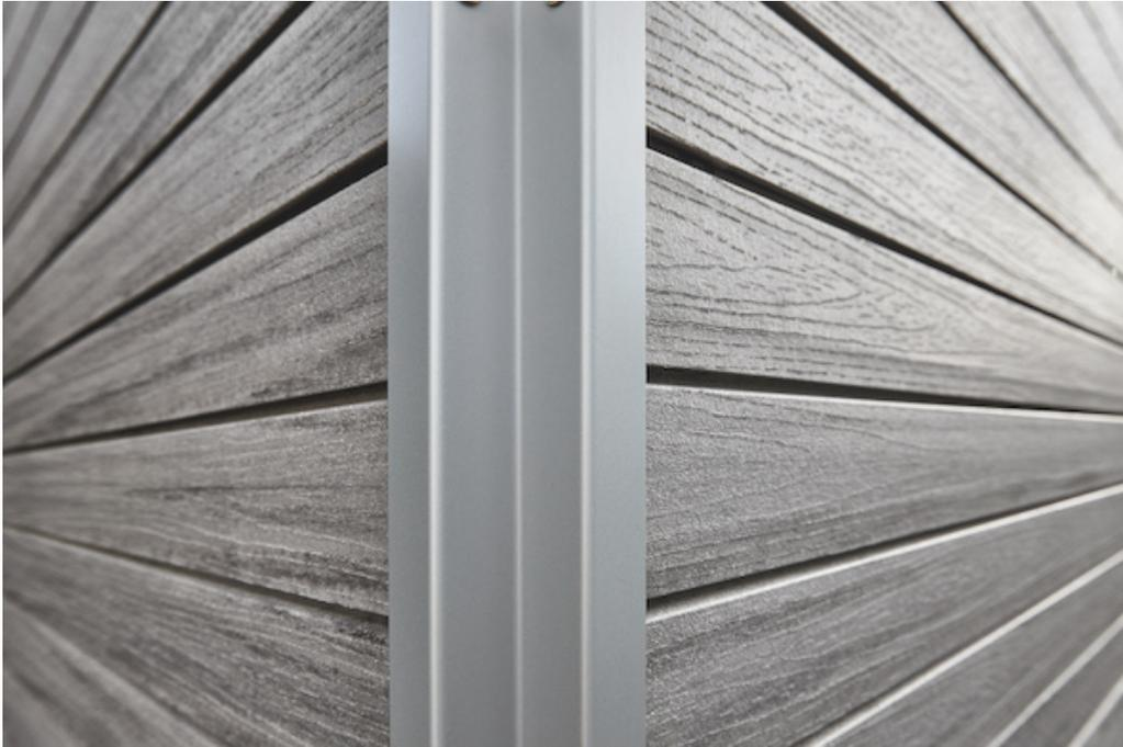
4 Die Rhombusleiste in der Ausführung „xl“ (Deckmaß 99 mm) war schnell verlegt. Für die Ecken wurden eigens angefertigte rechtwinklige Edelstahlleisten angebracht. Zusammen mit der naturidentisch geprägten Holzmaserung entsteht so eine edle und natürliche Optik in farblicher Einheit.
