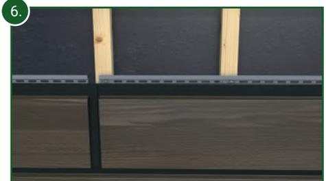
Die Position der Stoßverbindung kann sowohl auf einer Holzlatte (siehe Bild) als auch zwischen 2 Holzlaten (siehe Bild 7) erfolgen.
