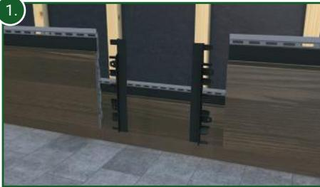
Schieben Sie den jeweils passenden linken oder rechten Verbinder seitlich in die Kammern am Ende der Fassadenprofile ein.
