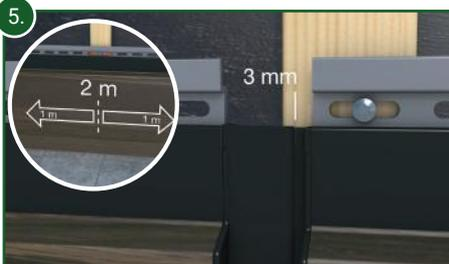
Bei der Montage von Fassadenprofilen mit Längen von 3 m kann die Breite der Dehnfuge auf 3 mm reduziert werden. Die genaue Position ist durch Markierungen auf dem unteren Verbinder gekennzeichnet.
