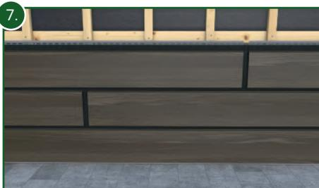
Die Position der Stoßverbindung kann sowohl zwischen 2 Holzlatten (siehe Bild) als auch auf einer Holzlatte (siehe Bild 6) erfolgen.
