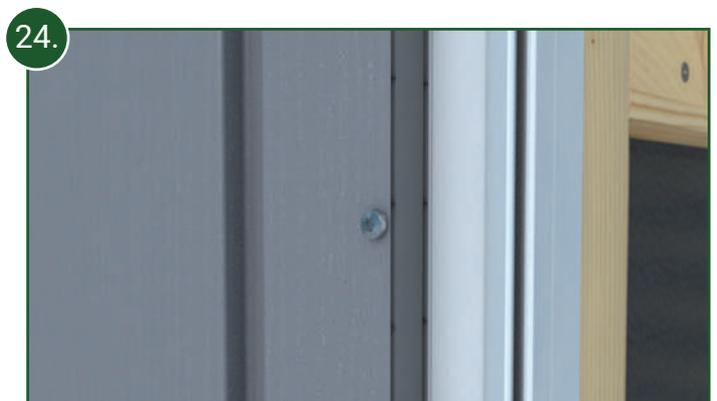
24. Anschließend wird das Profil fest mit der Traglattung verschraubt.
