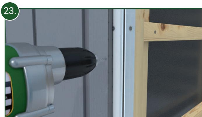
23. Das gekürzte Fassadenprofil wird mit ca. 10 mm Abstand zur Sägekante alle 30 cm vorgebohrt.
