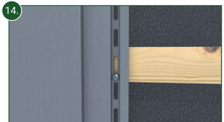
14. Fixieren Sie zu diesem Zweck in mittlerer Position eines jeden Profils eine Schraube ZWISCHEN 2 Langlöchern und verschrauben das Profil fest mit der Traglattung.
