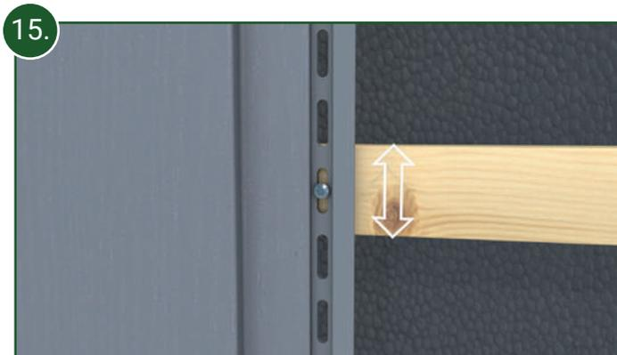
15. Alle weiteren Schrauben ober- und unterhalb werden nun mittig in den Langlöchern positioniert, so dass die Profile die Möglichkeit haben, sie in Längsrichtung auszudehnen bzw. zusammenzuziehen.
