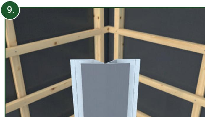
9. Verwenden Sie das variable Eckprofil (faltbar) für Innenecken, sowie für Außenecken mit einem Winkel kleiner als 90 Grad. Beim Einsatz als Innenecke knicken Sie das Profil nach innen, andernfalls nach außen.
