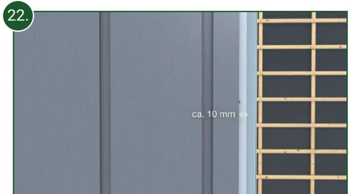
22. Der Abstand der Sägekante zum äußeren Ende des 2-teiligen Abschluss- oder Eckprofils muss 10 mm betragen.
