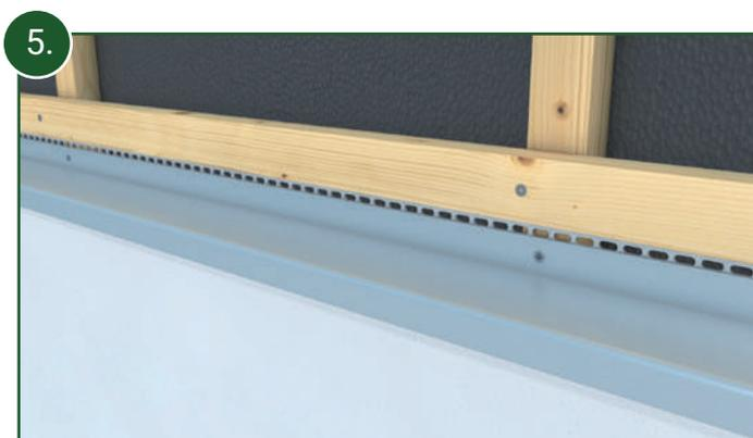
Die unterste horizontale Dachlatte wird nun bündig mit der Oberkante des Lüftungsprofils 40 x 30 mm mit dem Holz der Unterkonstruktion verschraubt.
