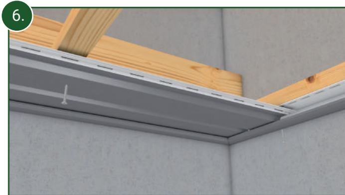
6. Die Verkleidungsprofile werden durch die Langlöcher auf der Traglattung verschraubt.
