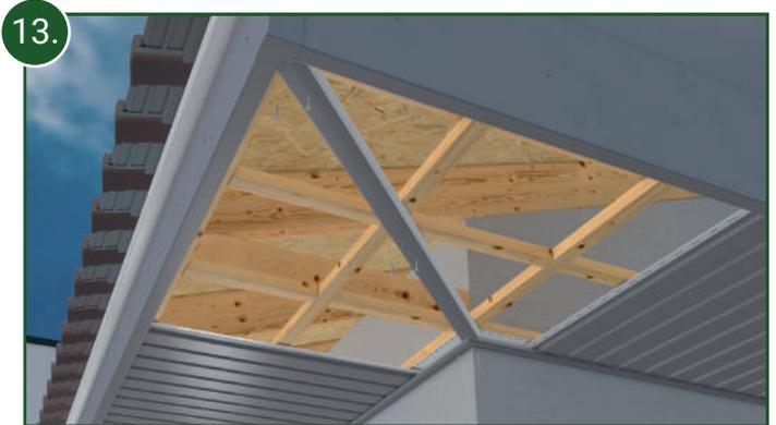
13. Das Verbindungsprofil wird auf der Traglattung mit den Edelstahlschrauben (DD004) befestigt.
