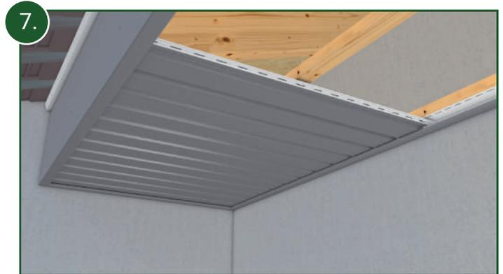
7. Das nächste Profil wird über das Erste geschoben/gesteckt. Dadurch werden die Schrauben auf der Federseite verdeckt. So können Sie nun ein Verkleidungsprofil nach dem anderen verarbeiten.
