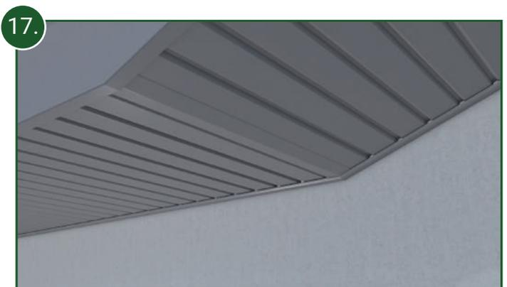
17. Nun werden die Verkleidungsprofile wie gewohnt montiert. Das variable Eckprofil fungiert als Abschlussprofil und Startprofil zugleich.
