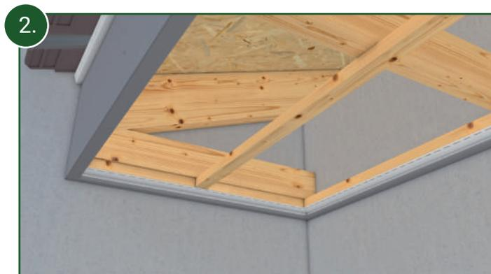
Als Erstes befestigen Sie die Abschlussprofile (DD410, alternativ DD210) auf dem äußeren Rand der Traglattung. Für die Verkleidung des Ortgangs können Sie unseren Hartschaumwinkel verarbeiten. In diesem Fall fällt das Abschlussprofil auf der Seite weg.
