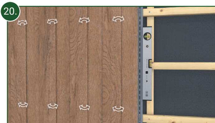
20. Die exakte Ausrichtung der Fassade sollte in regelmäßigen Abständen mit Hilfe einer Wasserwaage kontrolliert werden. Kleine Korrekturen sind jeweils beim Zusammenstecken der Profile möglich.
