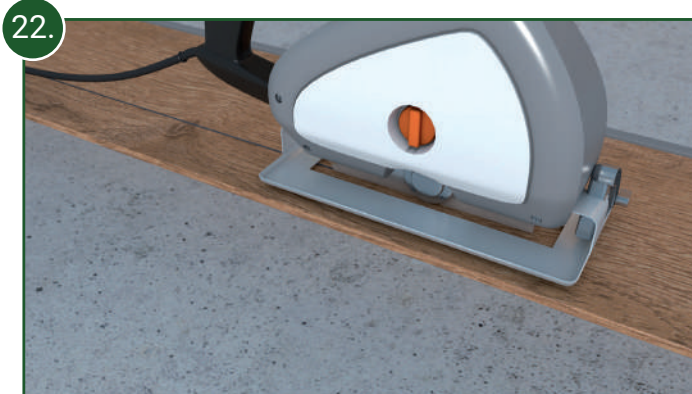
22. Die Kürzung kann problemlos mit Hilfe einer Stich- oder Handkreissäge erfolgen.
