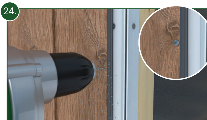
24. Das gekürzte Fassadenprofil wird mit ca. 10 mm Abstand zur Sägekante alle 30 cm vorgebohrt. Anschließend wird das Profil fest mit der Traglattung verschraubt.
